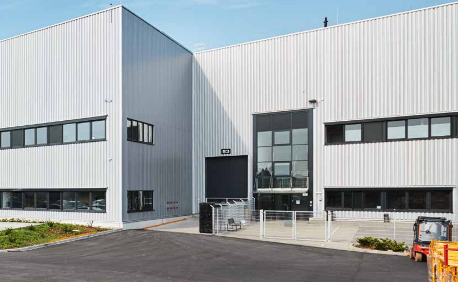
TST Logistikzentrum, Biebesheim
